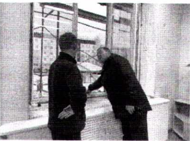
■ В детском саду «Сказка» продолжается работа по замене 78 оконных блоков ПВХ
