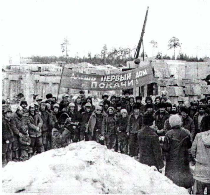
■ В первом капитальном доме Покачей строители заложили капсулу времени, которую потомки смогут распечатать через 100 лет / ФОТО ИЗ АРХИВА КРАЕВЕДЧЕСКОГО МУЗЕЯ
